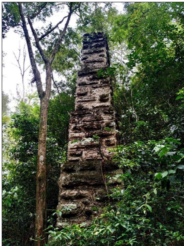
Figura 48 – Ruína de uma coluna de sustentação da tubulação de abastecimento da Fábrica. Coordenadas: 23 K 633.223 E / 7.500.864 N (HVNA, 2020).
